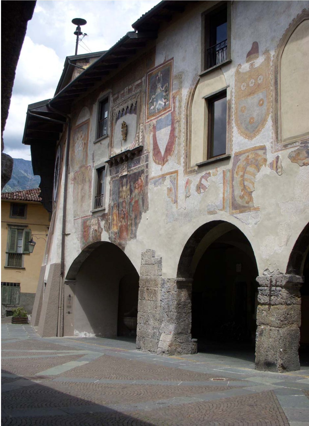
Façade principale de cette extraordinaire bâtisse.
